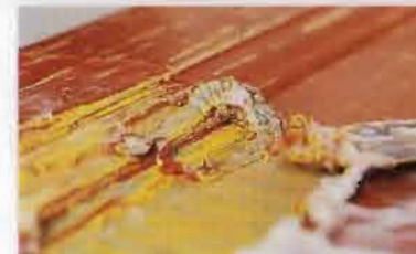
Соскребите растворитель и краску металлическим шпателем.
